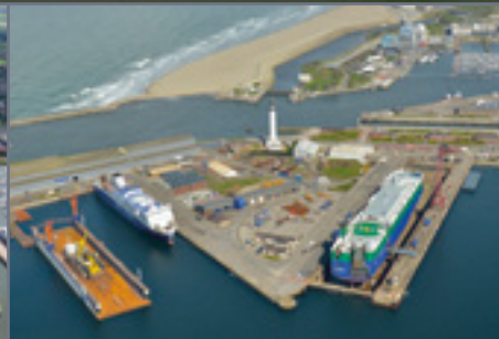
DAMEN SHIPREPAIR DUNKERQUE
